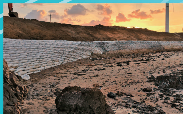
烟台海洋工程安全保障技术创新中心 滨海沙滩防护工程
