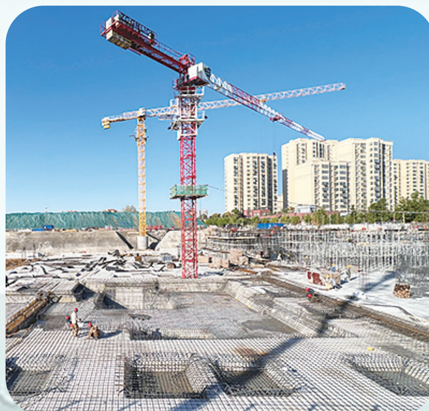
中安碧玺园项目现场
