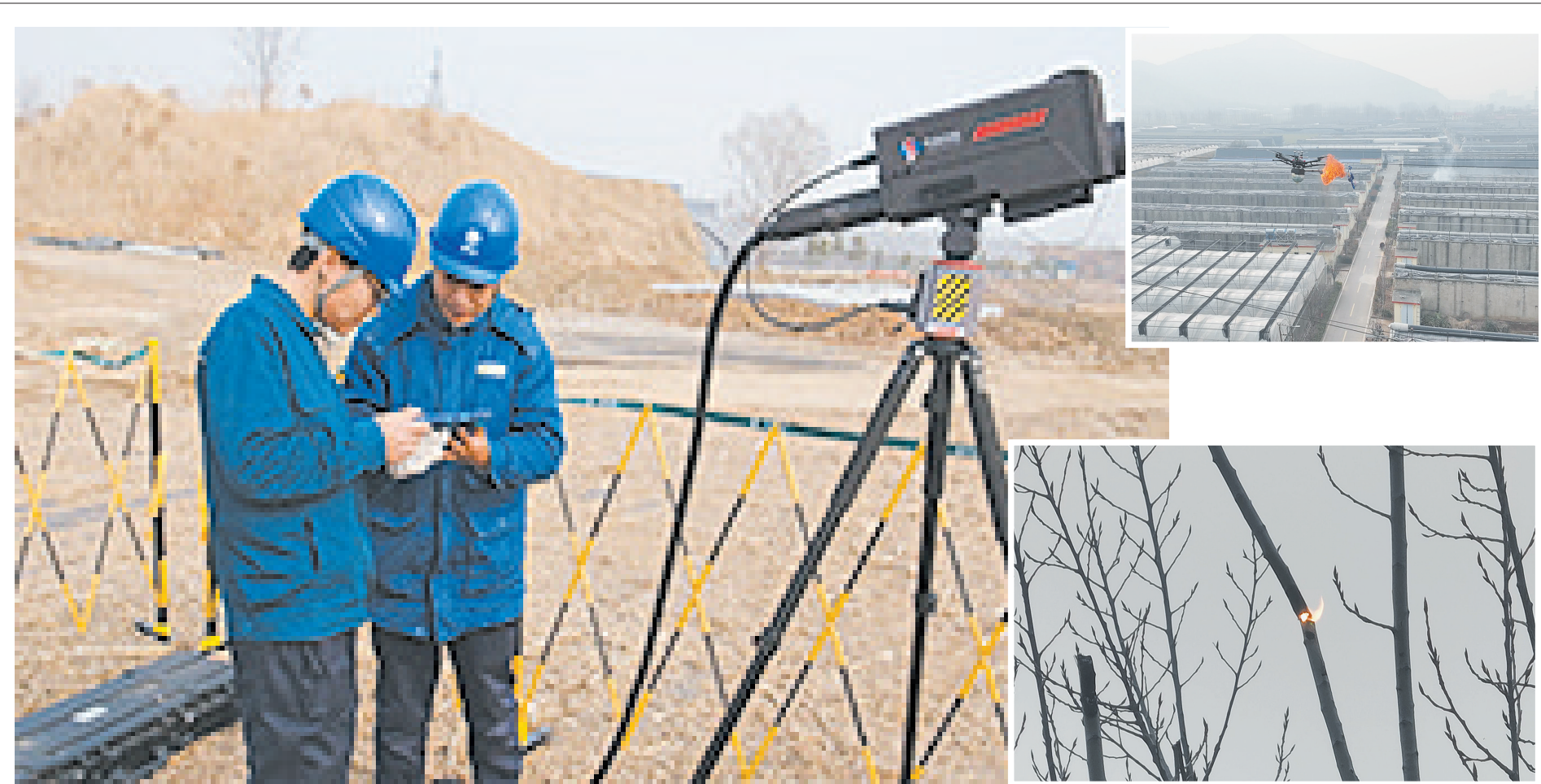
近日，供电部门工作人员使用黑科技——激光炮和喷火无人机进行作业，清理影响供电安全的树枝和缠绕在高空电线上的异物。该黑科技的投入使用极大提高工作效率。同时，供电部门提醒广大市民，不要在供电线路周边放风筝、乱扔垃圾，以免塑料袋随风缠绕在输电线路，对供电设施造成损坏。虽然科幻照进了现实，有了这些黑科技宝贝加持，可以更好地保障供电的安全，但是最可靠的保障还是提高安全意识。（记者 刘正航 实习记者 郑雪茹 通讯员 姜倩 刘帅 摄）
