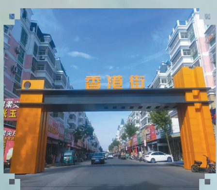
改造后的香港街新貌
