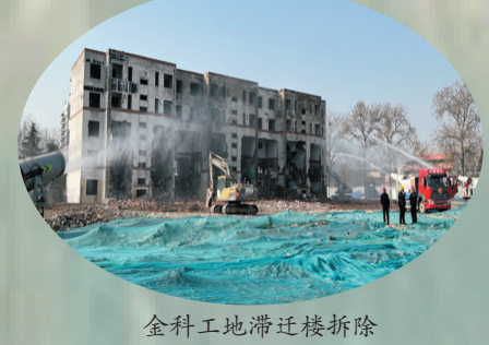
金科工地滞迁楼拆除
