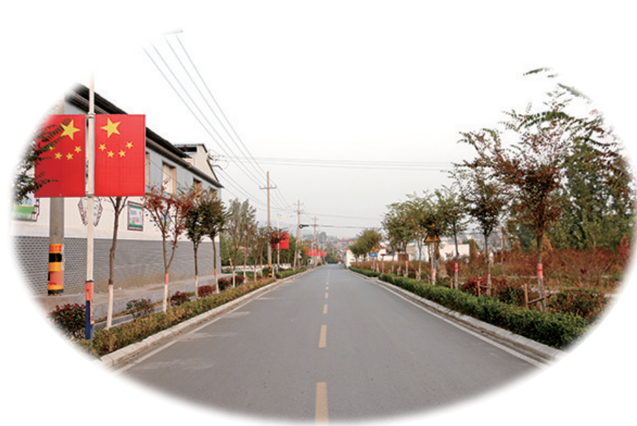
宽阔整洁的道路
